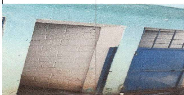
Foto 4.2 Sustitucion de puerta
