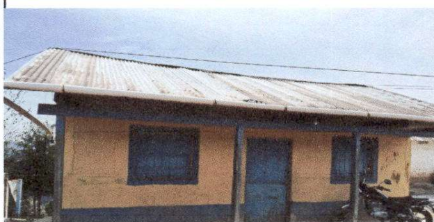
Foto 1.1 sustitucion de lamina por lamina troquelada aluzinc calibre 26
