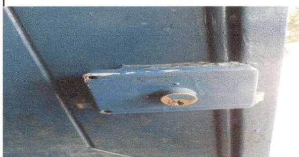
Foto 4.1 sustitucion de chapa
