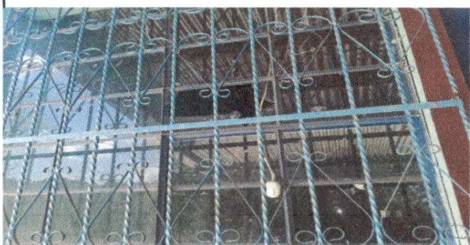
Foto 5.4 mantenimiento a balcones de metal
