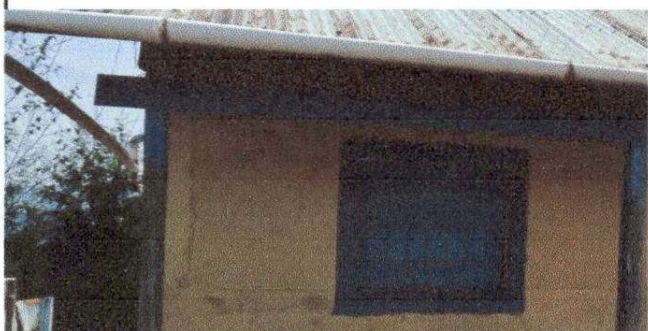
Foto 5.2 Sustitución de ventana d madera de metal mas vidrio
