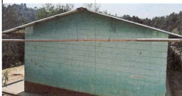
Foto 1.2 Sustitucion de lamina por lamina troquelada aluzinc calibre 26
