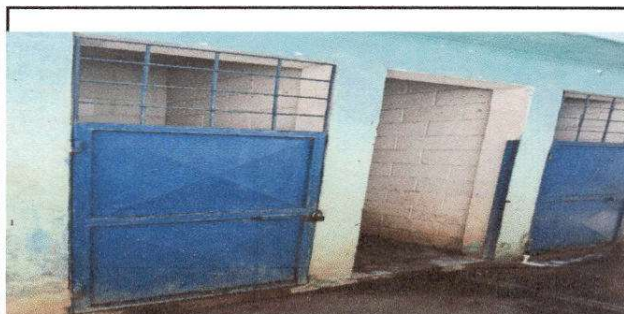
Foto 4.3 mantenimiento a estructura (lijado a cambio de tuvo, cepillado,sujetaciones aplicacion de pintura)
