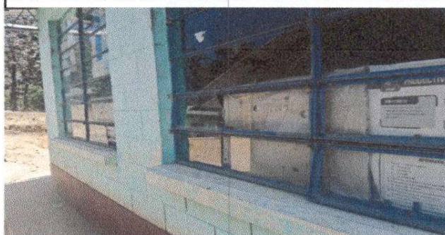
Foto 5.3 sustitucion de vidrios
